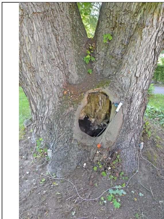
Fot. 12.13. Klon srebrzysty nr inw. 62, Zespół Szkół nr 3 im. Mikołaja Reja w Kędzierzynie-Koźlu. Próba obciążeniowa - miejsce mocowania czujników - strona ściskana.
