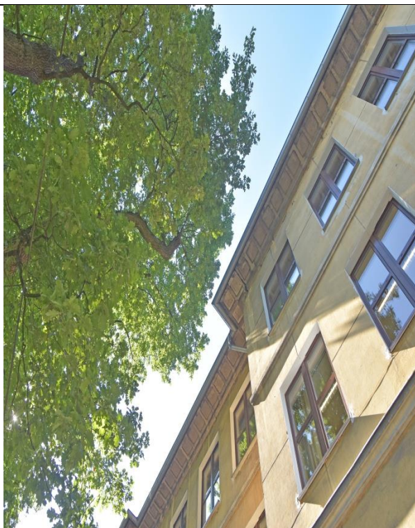
Fot. 27.4. Dąb szypułkowy nr inw. 109, Zespół Szkół nr 3 im. Mikołaja Reja w Kędzierzynie-Koźlu. Korona wychodząca nad dach budynku.
