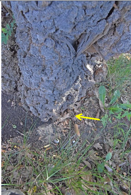
Fot. 19.3. Robinia akacjowa nr inw. 82, Zespół Szkół nr 3 im. Mikołaja Reja w Kędzierzynie-Koźlu. Rozkład w szyi korzeniowej – od strony ściskanej. Strzałką zaznaczono miejsce wbicia sondy.
