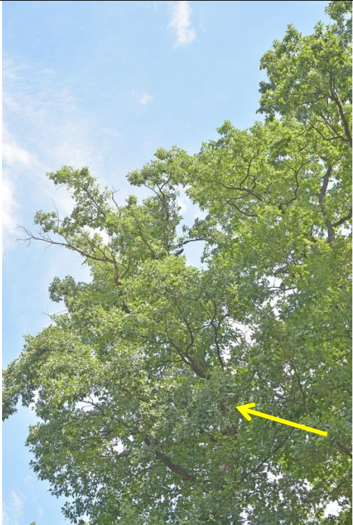
Fot. 7.3. Dąb szypułkowy nr inw. 10, Zespół Szkół nr 3 im. Mikołaja Reja w Kędzierzynie-Koźlu. Konar wyrastający z osłabionego przewodnika.
