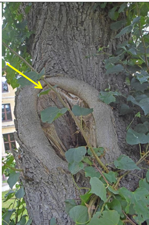
Fot.35. 4. Lipa holenderska nr inw. 173, Zespół Szkół nr 3 im. Mikołaja Reja w Kędzierzynie-Koźlu. Miejsce po usuniętym konarze z ubytkiem wgłębnym.
